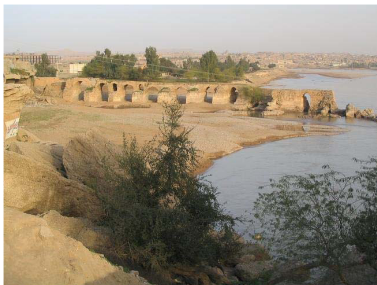
او از این نیروی عظیم که در اختیارش بود بهره گرفت و در سال ۲۶۰ میلادی دستور ساختن سیستم آبرسانی و سد بزرگی را بر رودخانه ای که بین شهر شوش پایتخت ایلامیان و پرسپولیس پایتخت هخامنشیان جریان داشت بسازند. این سد به طول ۵۵۰ متر (بیش از نیم کیلومتر) توسط سربازان ششمین لژیون معروف او ساخته شد که از آن به عنوان پل هم استفاده میشود.
